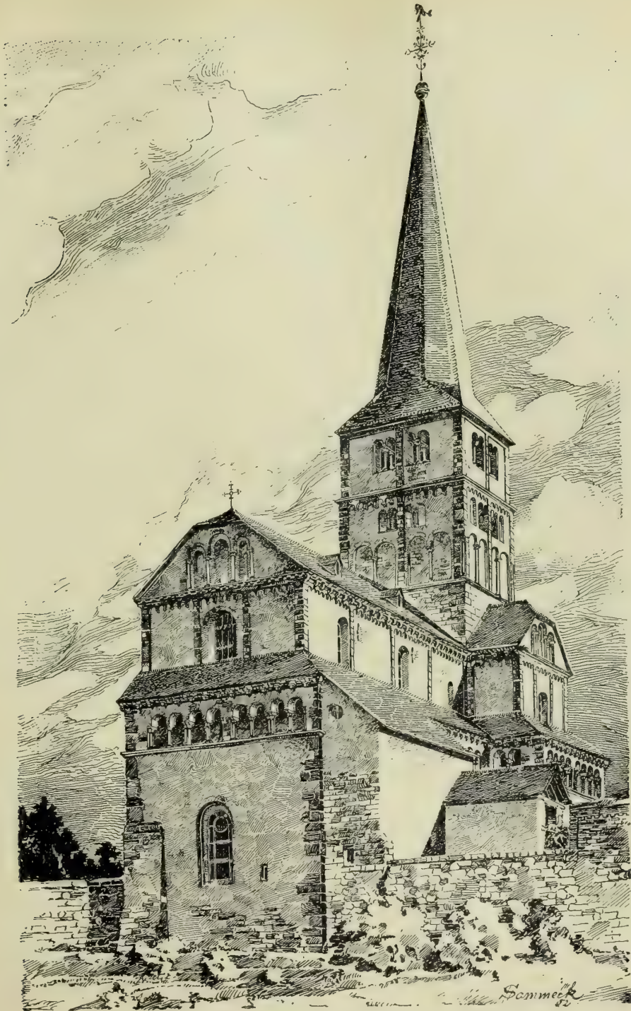
Fig. 235. Schwarzhof. Westansicht der Doppelkapelle vor der Restauration.
